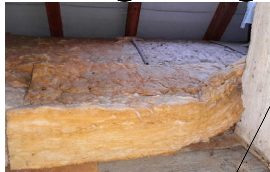
Dämmung zum Dachboden
