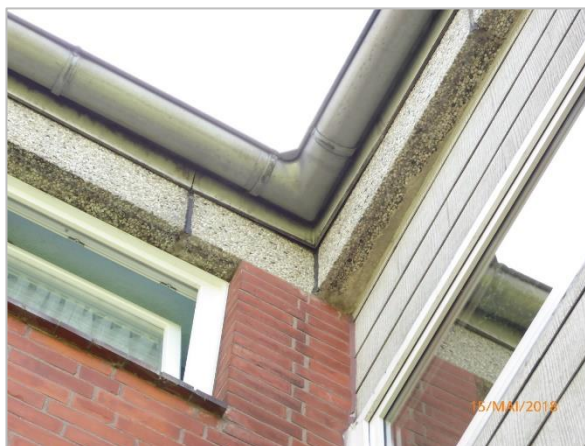
Foto 7: Im Traufbereich umlaufende Blende als weiterer geeigneter Fledermausquartierstandort
