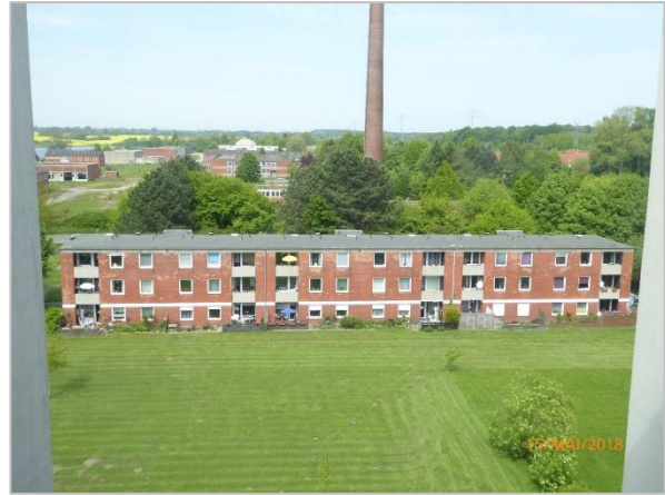
Foto 4: Sicht aus dem angrenzenden Hochhaus auf ein dreigeschossiges Wohngebäude (Gebäude Nr. 6) mit großflächiger Grünanlage.
