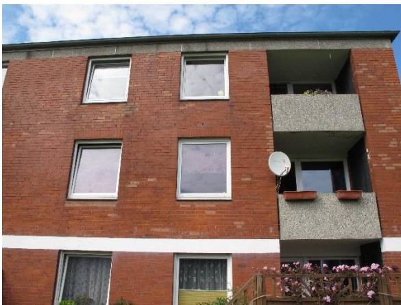
Foto 5: Lüftungsspalte im Verblendmauerwerk stellen geeignete Fledermausquartiere dar.
