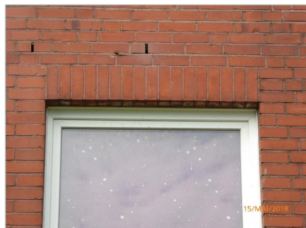
Foto 6: Detailaufnahme Lüftungsspalat.
